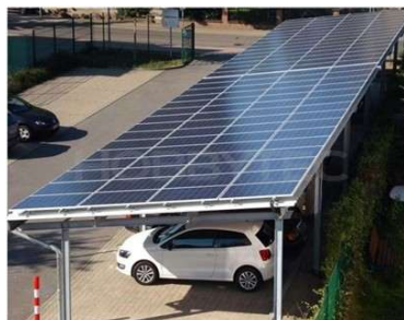
Parkoviště s fotovoltaikou
